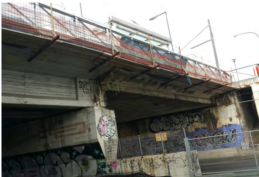
Εικόνα 3. Γέφυρα Γρηγορίου Λαμπράκη.
